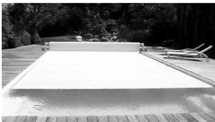
Piscine munie d'un volet roulant
