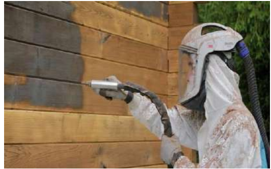
Figure 1 : Nettoyage d'une surface par aérogommage
