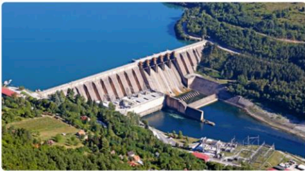
Barrage hydroélectrique en Serbie
