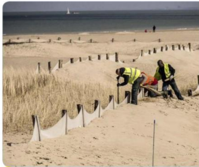
6 La protection du cordon dunaire. Des aménagements en bois (ganivelles) sont installés afin de piéger le sable transporté par le vent. Une fois la dune stabilisée, elle peut accueillir une végétation typique (ici des oyats) qui participe au maintien du sable en place. Les ganivelles préservent les dunes de l'impact du piétinement.
