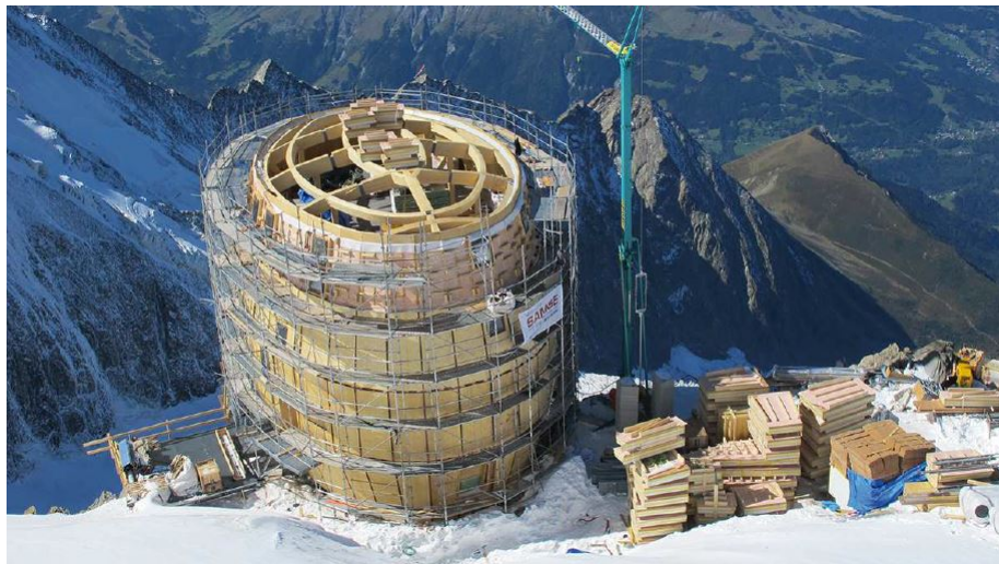
FIGURE 1 – Le refuge du Goûter en construction
